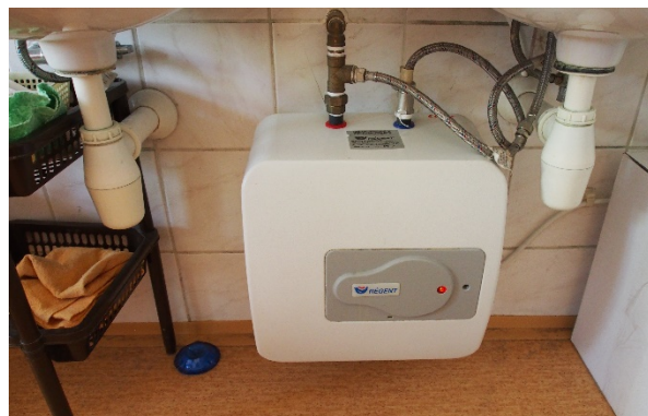
Obrázek 35 - Další příklad lokální přípravy TV - ZŠ
