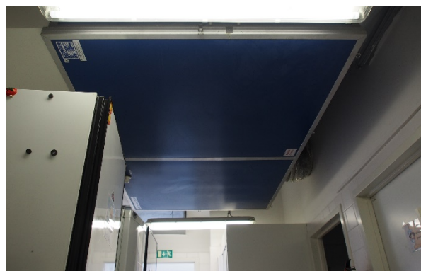
Obrázek 23 - Větrací jednotka pro kuchyň
