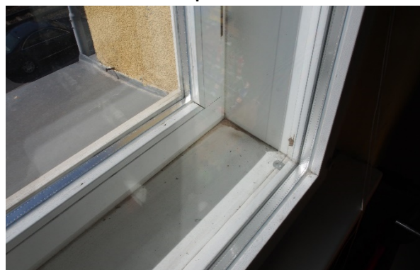
Obrázek 31 – Okna dvojsklo v obou křídlech - ZŠ
