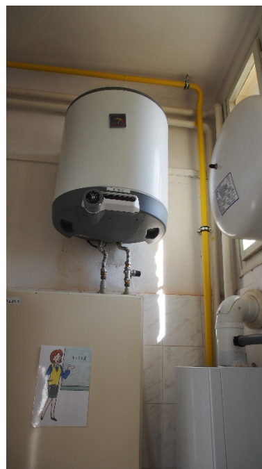
Obrázek 21 – Příprava TV – Dražice OKCE
