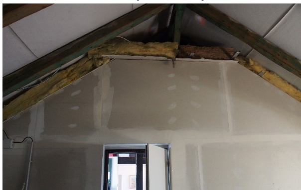
Obrázek 32 – Zateplená vestavba podkroví - ZŠ
